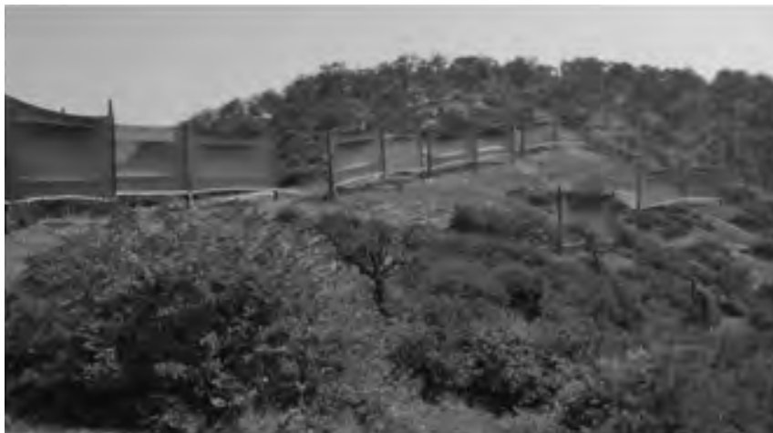
Figura 3 Sistema de atrapanieblas en las lomas de Atiquipa
